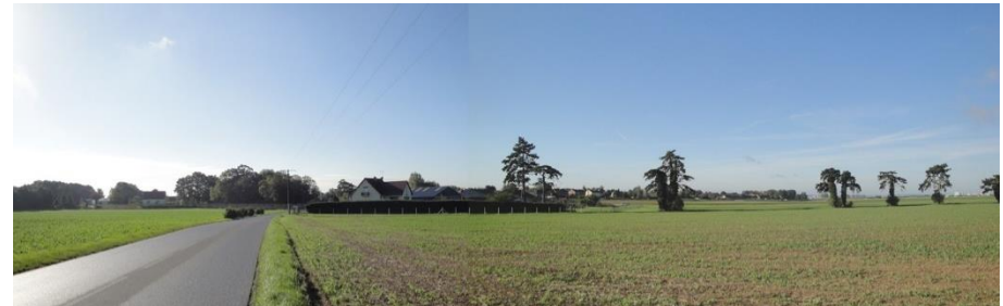
Entrée nord : le pavillon construit en extension dénote dans la silhouette assez végétale.
