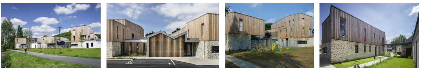
Espace Jean-Baptiste Denonville - Rives-en-Seine [76] – 4 259 hbts Maison des services publics, structure multi-accueil, maison médicale et 8 logements Agape architectes, Sispeo architectes - Crédit photos : Sandro Di Carlo Darsa
