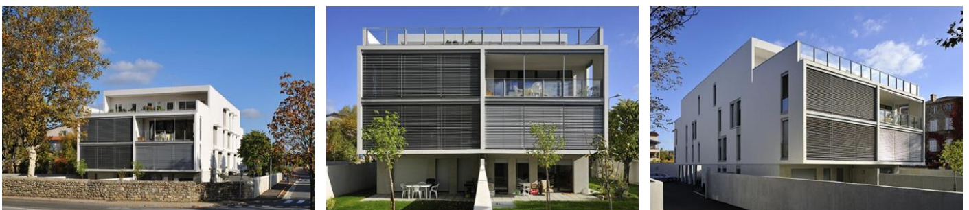
Les Tilleuls - Mornant [69] – 5 938 hbts 14 logements en accession (2 T2, 9 T3, 3 T4) et 42 places de stationnement + aménagement des espaces extérieurs Emprise foncière : ~ 4 300 m 2 Atelier Vera et Barrand architectes - Crédit photos : Erick Saillet et Atelier Vera & Barrand architectes
