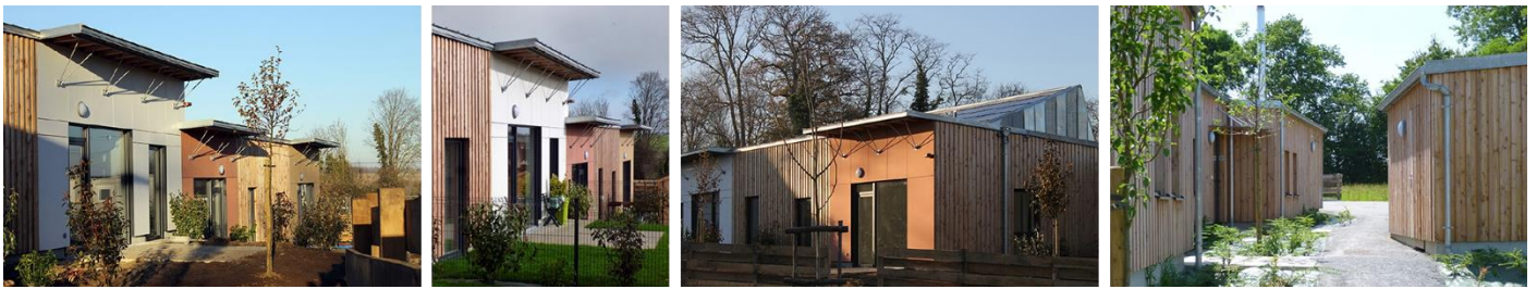
La Petite Fontaine - Bucéels [14] – 397 hbts 6 logements individuels accessibles PMR (personnes âgées) - Habitat individuel groupé KVA, N. Knapp et F. Versavel - Crédit photos : KVA, N. Knapp et F. Versavel
