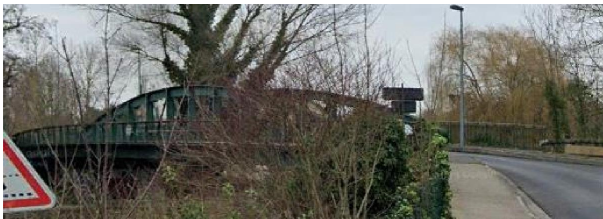
Photo 26 – Franchissement d'un bras de la Somme rue Marius Petit avant le centre-ville
