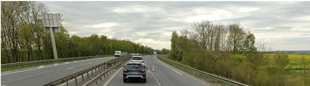
Photo 10 - Les linéaires de la rocade N25 au droit du passage faune souterrain
