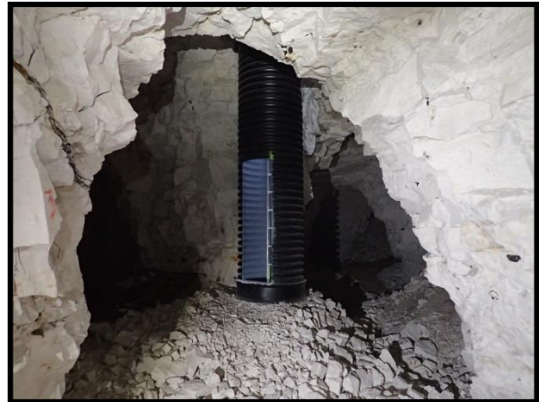
Photo du puits depuis la carrière
