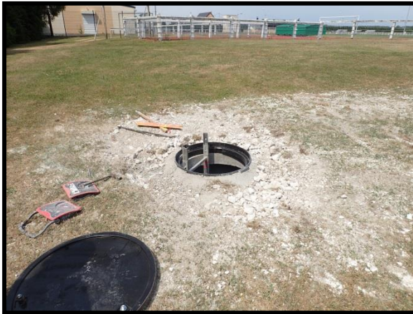
Puits d'accès à la carrière implanté dans l'emprise du stade.
