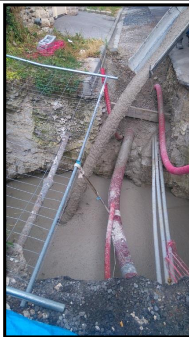
Comblement avec du coulis depuis la surface (toupie)
