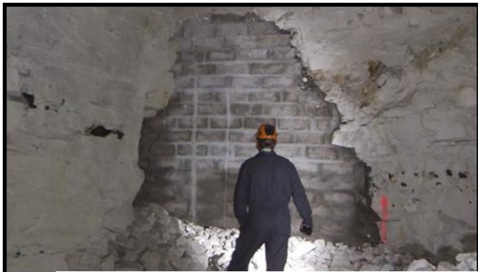
Construction des murs de confinement
