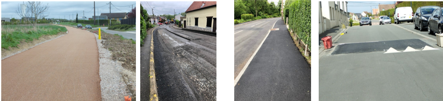
Création de pistes cyclables route de Corbie et rue Roger Salengro, travaux de rénovation caniveaux et trottoirs rue Marius Petit, et création d'un ralentisseur rue du Stade en mai 2024
